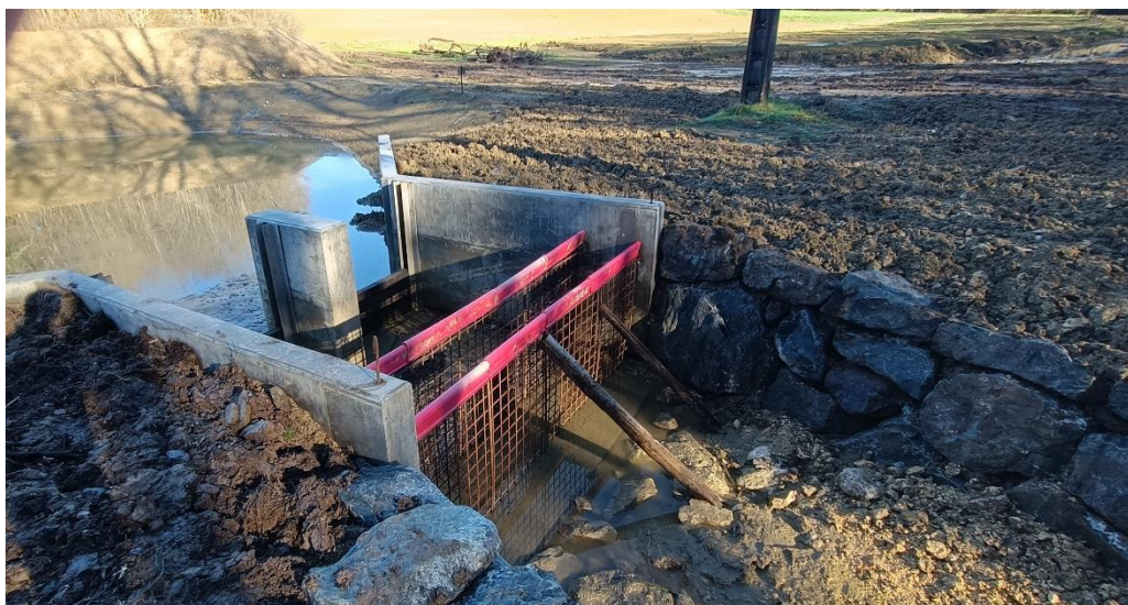
1 er Filtre juste en aval du bassin du décantation
