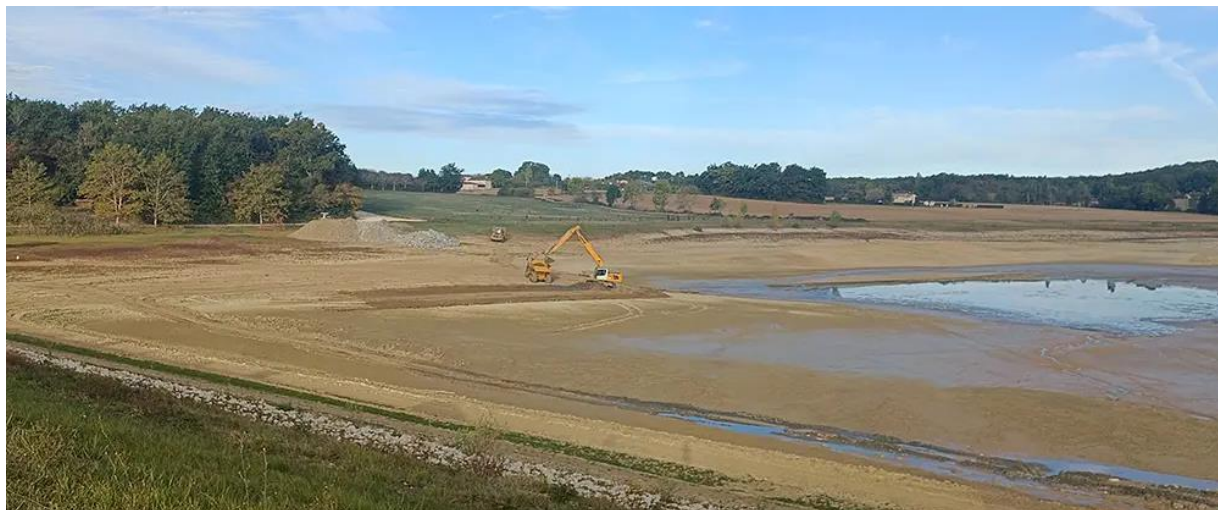
Vue sur le démarrage du curage de la cuvette du lac de la Ganne
