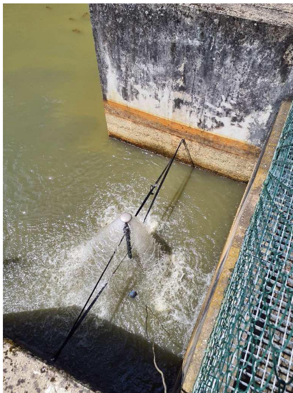
Photographie du dispositif d'aération mis en place en sortie de la retenue de Graussettes
