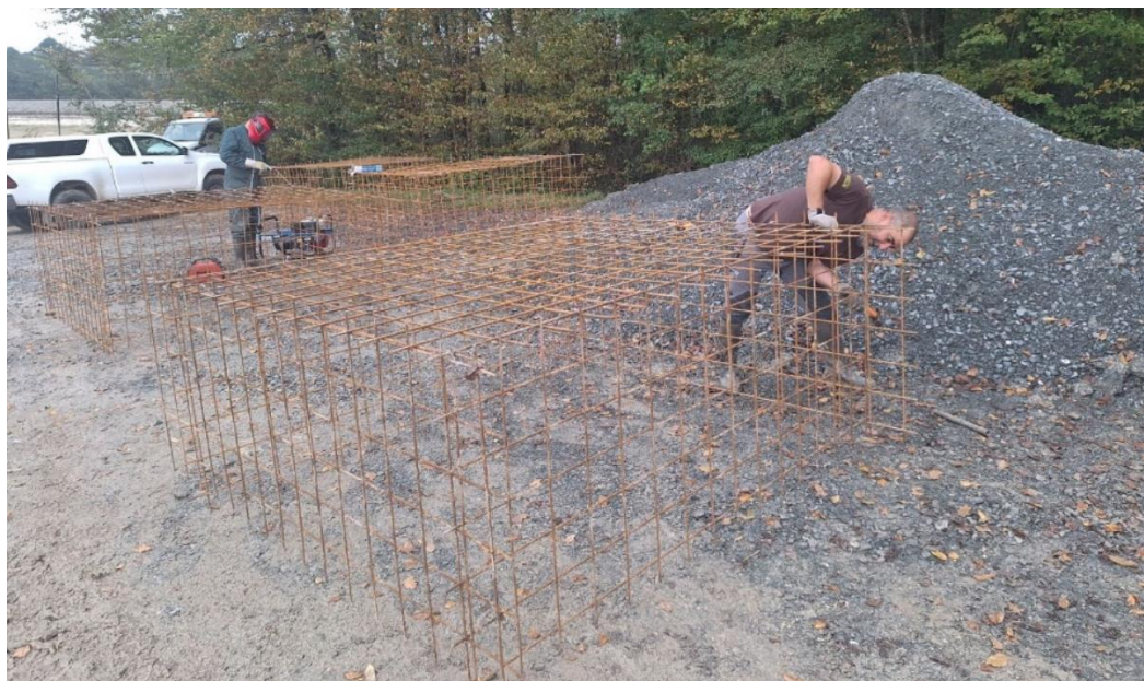
Montage des cages en treillis soudés.
