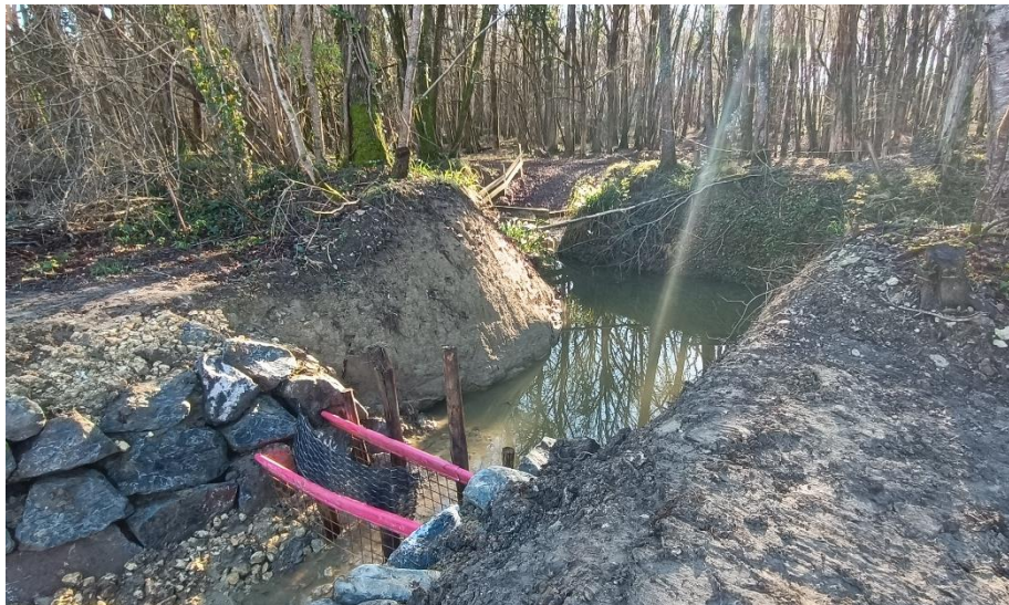
2 ème filtre en aval du 1 er filtre
