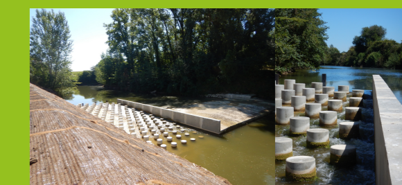
Fin des travaux en août 2020
