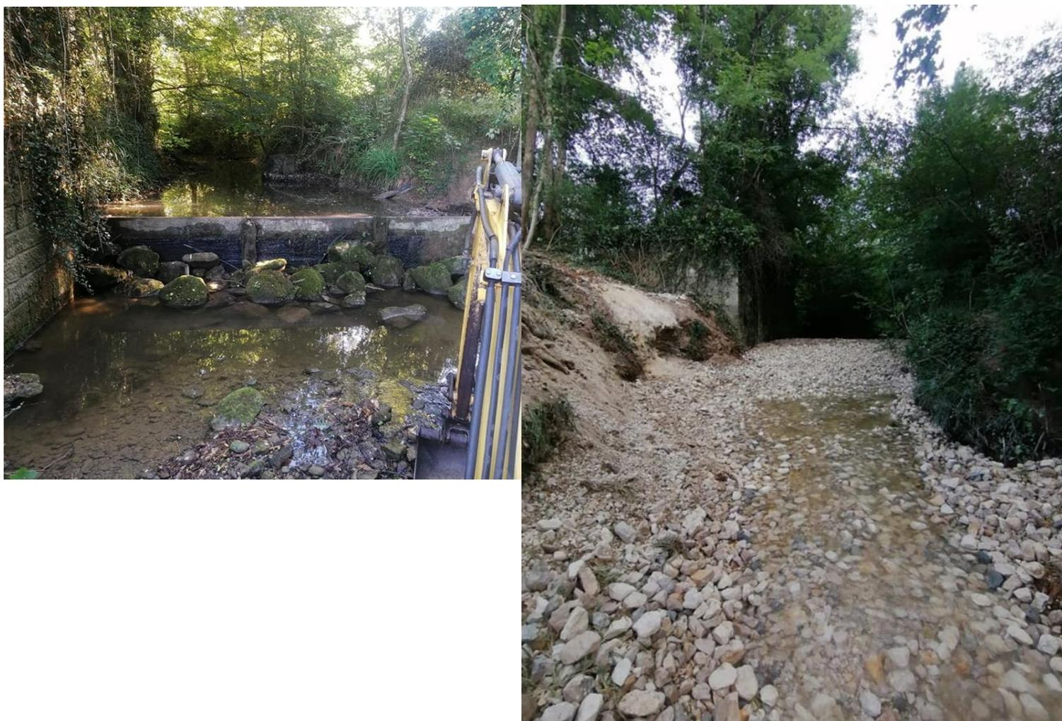
**Photos 10 et 11 : Recharge granulométrique à l'aval de l'ouvrage de charrier sur le Ségur**
