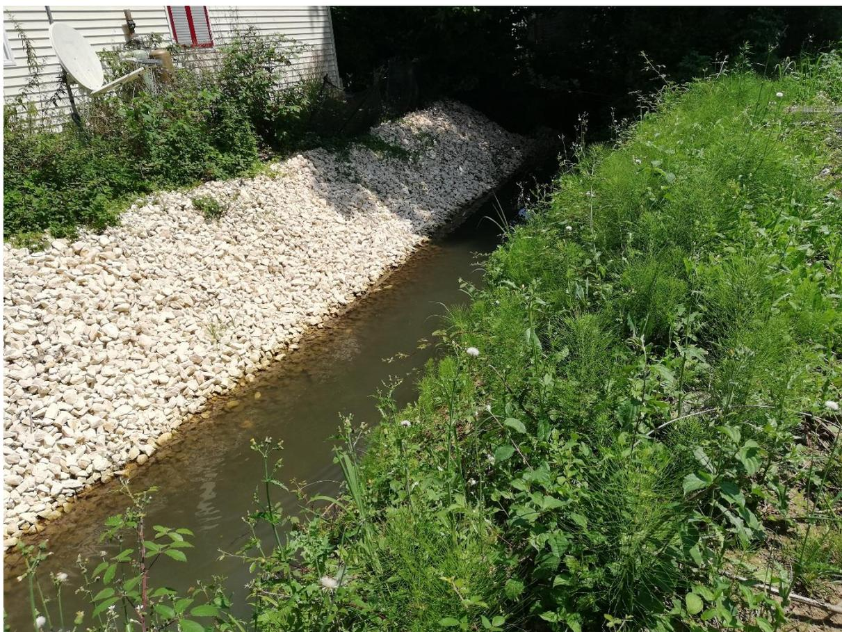
Le montant des travaux est de **6 023 € HT** pour la mise en place de 108 tonnes de 40/80 par l'entreprise Jolibert TP.
