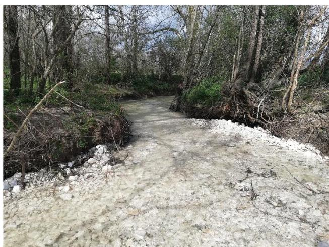
**Photo 41 : Recharge granulométrique (Dropt amont)**
