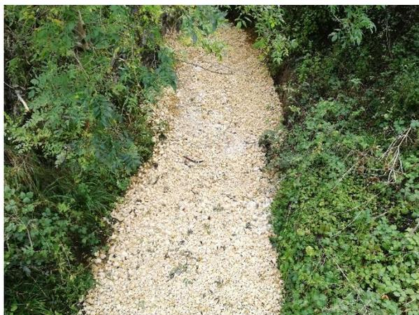
**Photo 42 : Recharge granulométrique à l'aval d'ouvrage sur la Bournègue**
