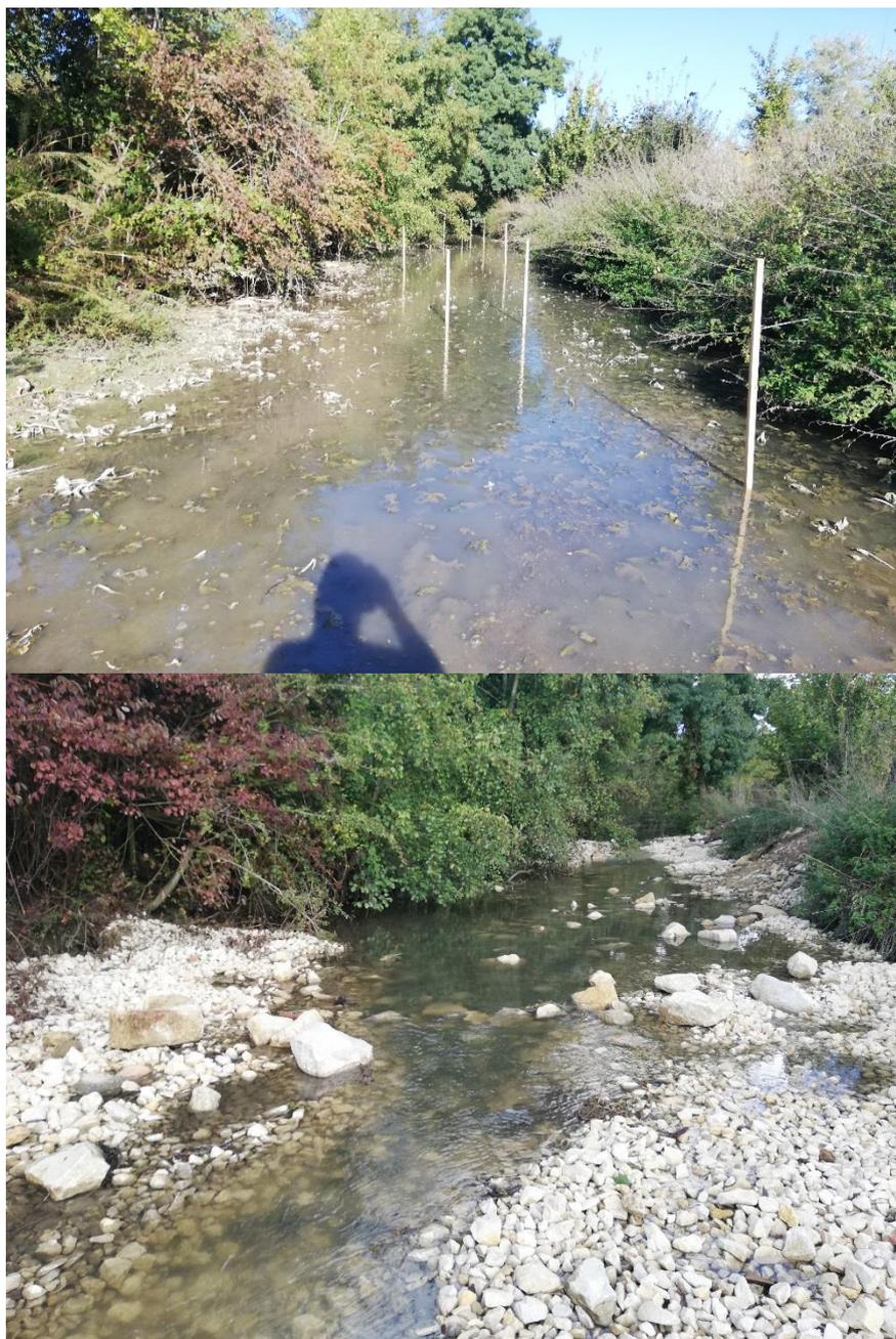
***Photos 37 et 38 : Avant et après restauration hydromorphologique sur le Dropt***
