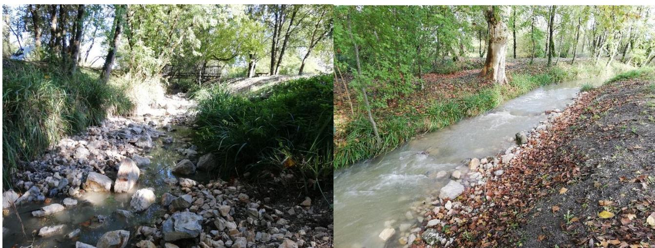
***Photo 15 : Diversification granulométrique sur la Banège à Issigeac***
