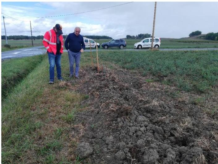
***Photo 35 : Contrôle de la distance d'implantation par rapport au domaine public routier par les services voiries du Département 24***
