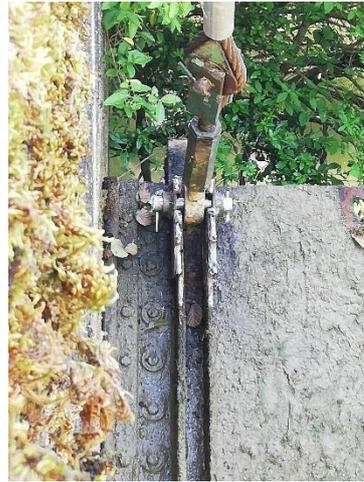
***Photos 27 et 28 : Nouvelle attache à Laborie et remplacement de l'axe à Joncadis***
