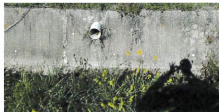
Annexe 1 Sortie de drain collecteur des risbermes
