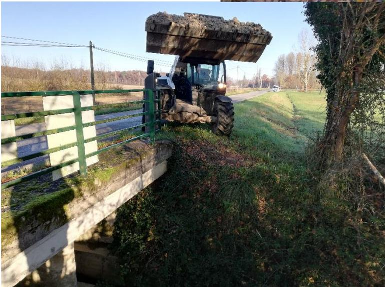
**Photo 40, 41 et 42 : Recharge granulométrique à l'aval des ouvrages**
