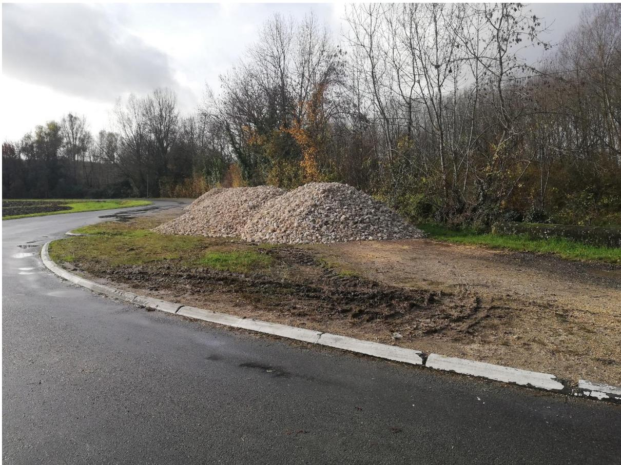
**Photo 39 : Granulat 10/150 qui sera utilisé pour le chantier de restauration hydromorphologique sur le Dropt à Lalandusse**
