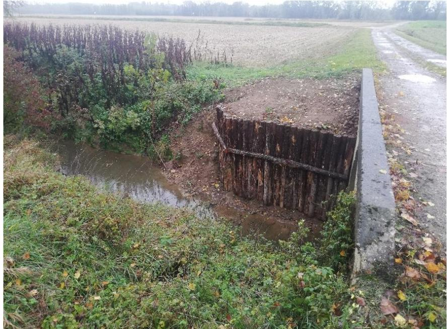
*Figure 15 : Photo après travaux du renforcement de berge*
