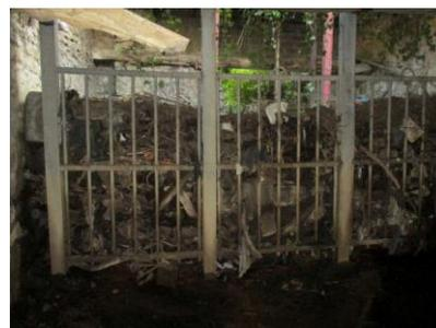
Figure 12 : Illustration des dépôts en amont de la grille de protection.
