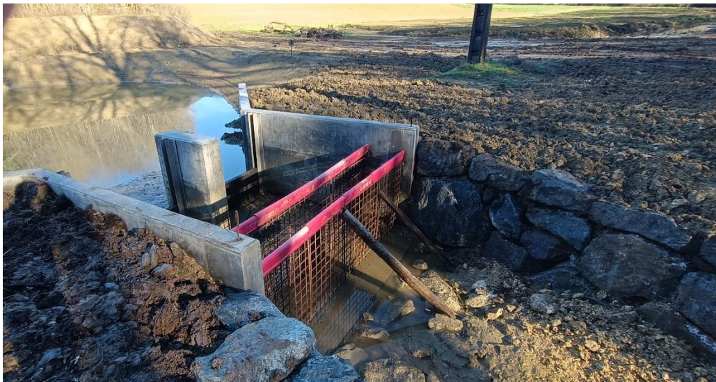
1 er Filtre juste en aval du bassin du décantation
