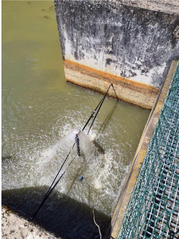
Photographie du dispositif d'aération mis en place en sortie de la retenue de Graoussettes
