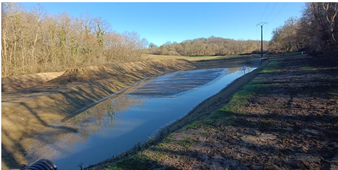
Bassin de décantation créé en septembre 2023
