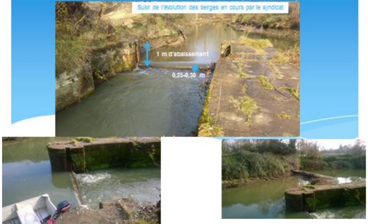
Un suivi de l'évolution des berges a été effectué par le technicien rivière. Les berges et la végétation se sont bien adaptées (pas d'érosion, ni même de dépérissement de la végétation rivulaire car la ligne d'eau est proche du système racinaire des arbres.)
